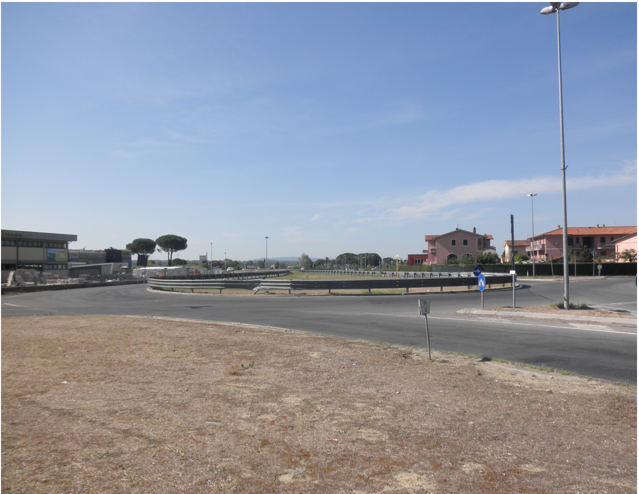
area compresa tra l'intersezione della strada provinciale SP66 Nuova Francesca, via S. Donato, via Colombaie e via strada Provinciale SP5 Francesca - Vista aiuola centrale arrivando da Castelfranco-
